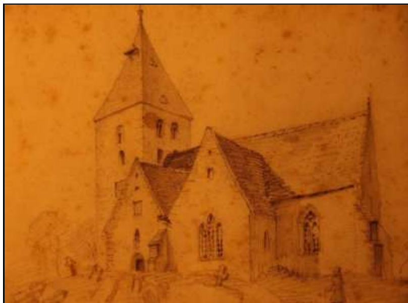
Ludwig Menke / Kirche in Heiligenkirchen / 1850 / Bleistiftzeichnung (am Turm sichtbar die kreuzförmigen Eisenanker, angebracht zur Reparatur nach dem Erdbeben von 1767)
